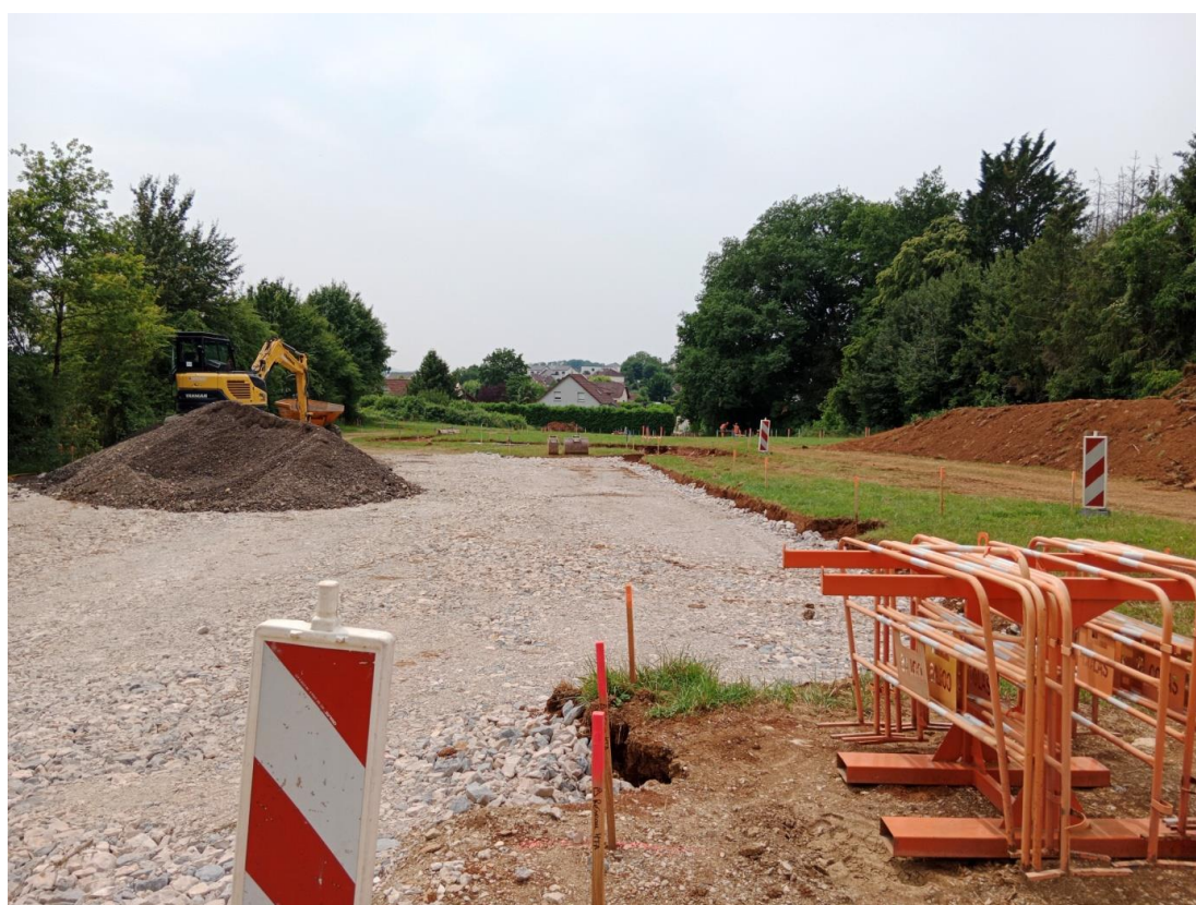
Emplacement des futurs vestiaires avec parking et boulodrome
