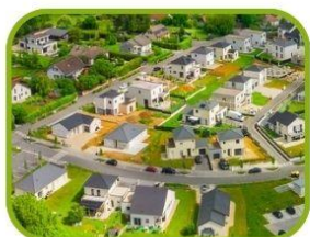
Travaux de la tranche 3
