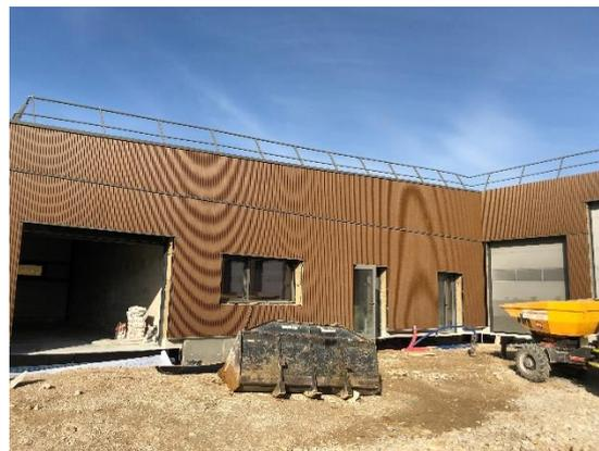
**Bardage extérieur en matériau recyclé**
