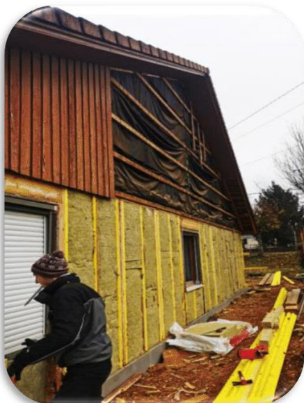
Démontage de la façade
