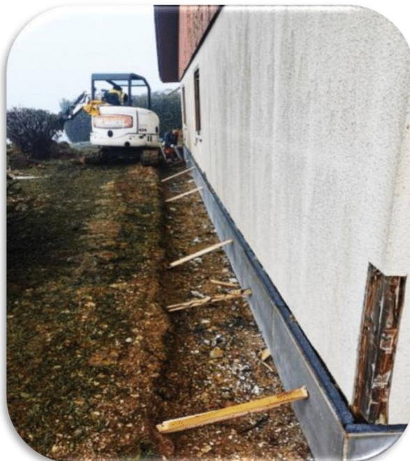
Rénovation du réseau d'eau pluviale
