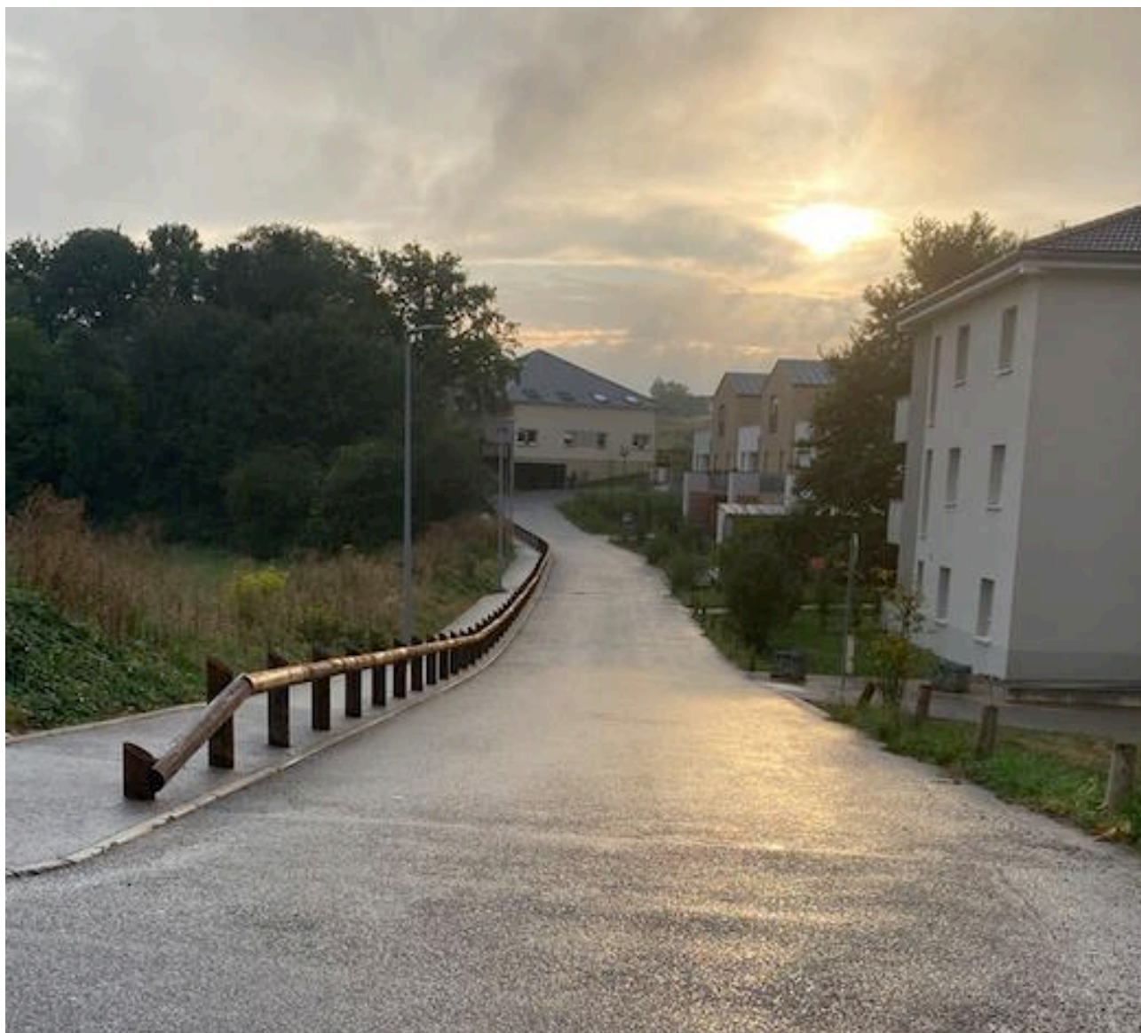
Photo réalisée à la fin du chantier en septembre 2021
