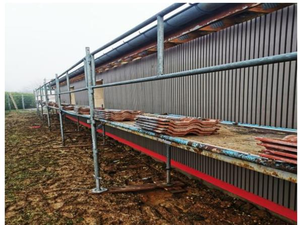
Renforcement de l'ossature bois, mise en place de l'isolant, des gouttières et de l'avant toit
